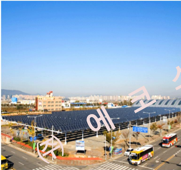
김대중 컨벤션 센터의 주차장에 구축된 태양광발전 시스템
